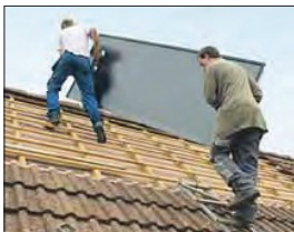
Eine Solaranlage auf dem Dach spart ein bis zwei Tonnen CO 2 pro Jahr. 20
