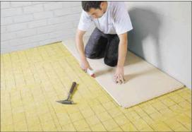
Nun wird der Spanplattenboden verlegt. Nut und Feder mit Holz-Kaltleim verkleben. Die Spanplatte «schwimmt» auf der Dämm-platte und wird nicht mit ihr verklebt.
