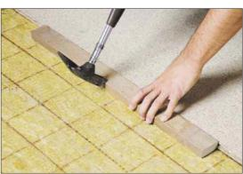
4 Die Fugen werden durch Klopfen bündig verschlossen. Ein Schlagholz dient dabei als Kantenschutz.
