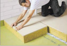
Der Spanplattenboden wird ebenfalls versetzt verlegt. Kreuzfugen sind auch hier zu vermeiden.
