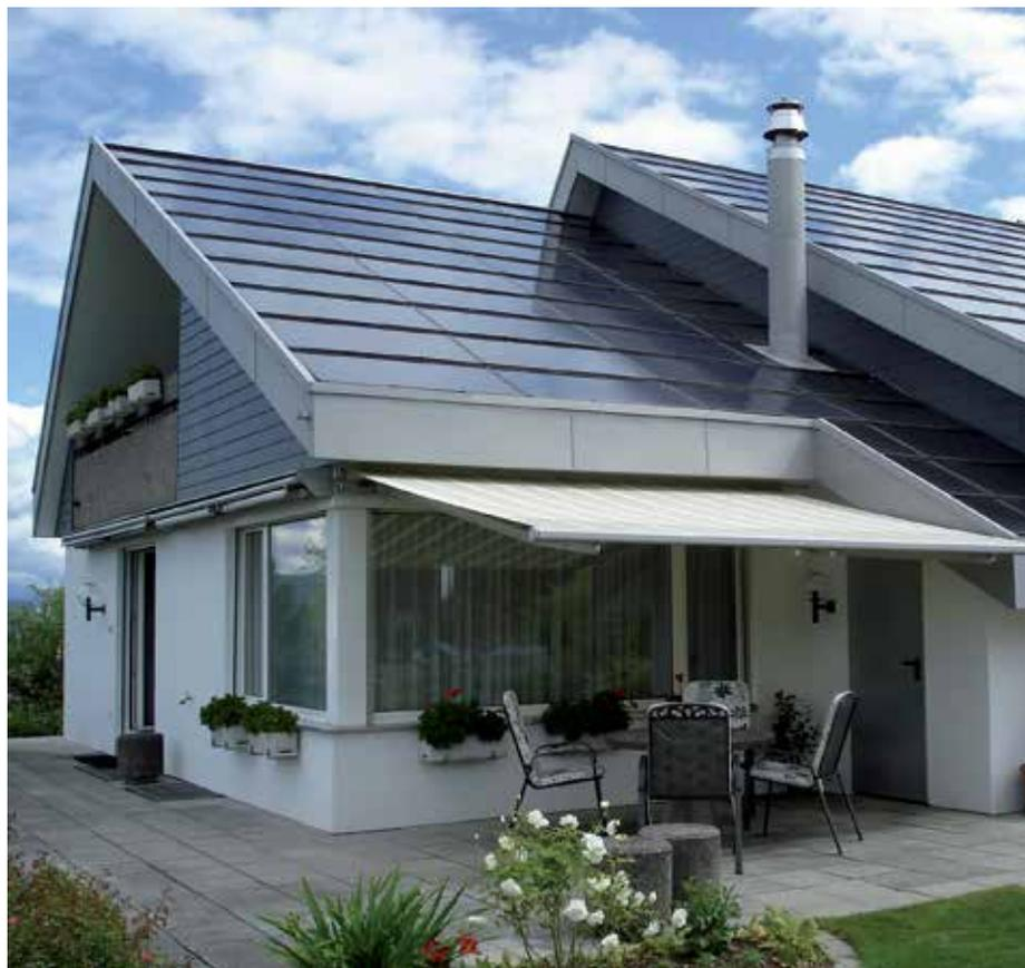
Durch mehrere Sanierungsschritte konnte der Energiebedarf auf gut 25 Prozent des ursprünglichen Bedarfs reduziert werden. Die 20,25 kWp-PV-Anlage liefert jährlich rund 21 000 kWh.
